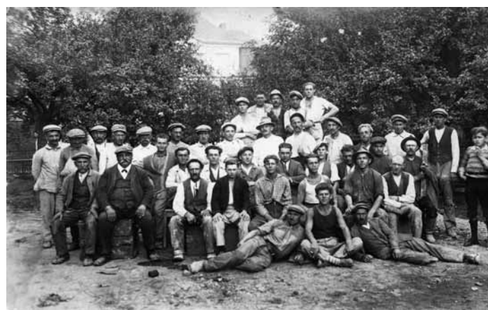
Fotografie z dokončení stavby nové školy v roce 1912 nebo 1913.
